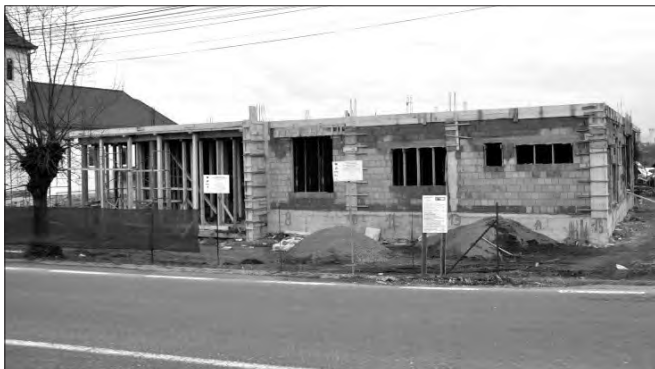
Az épülő bölcsőde. Fotó: Vajda György
